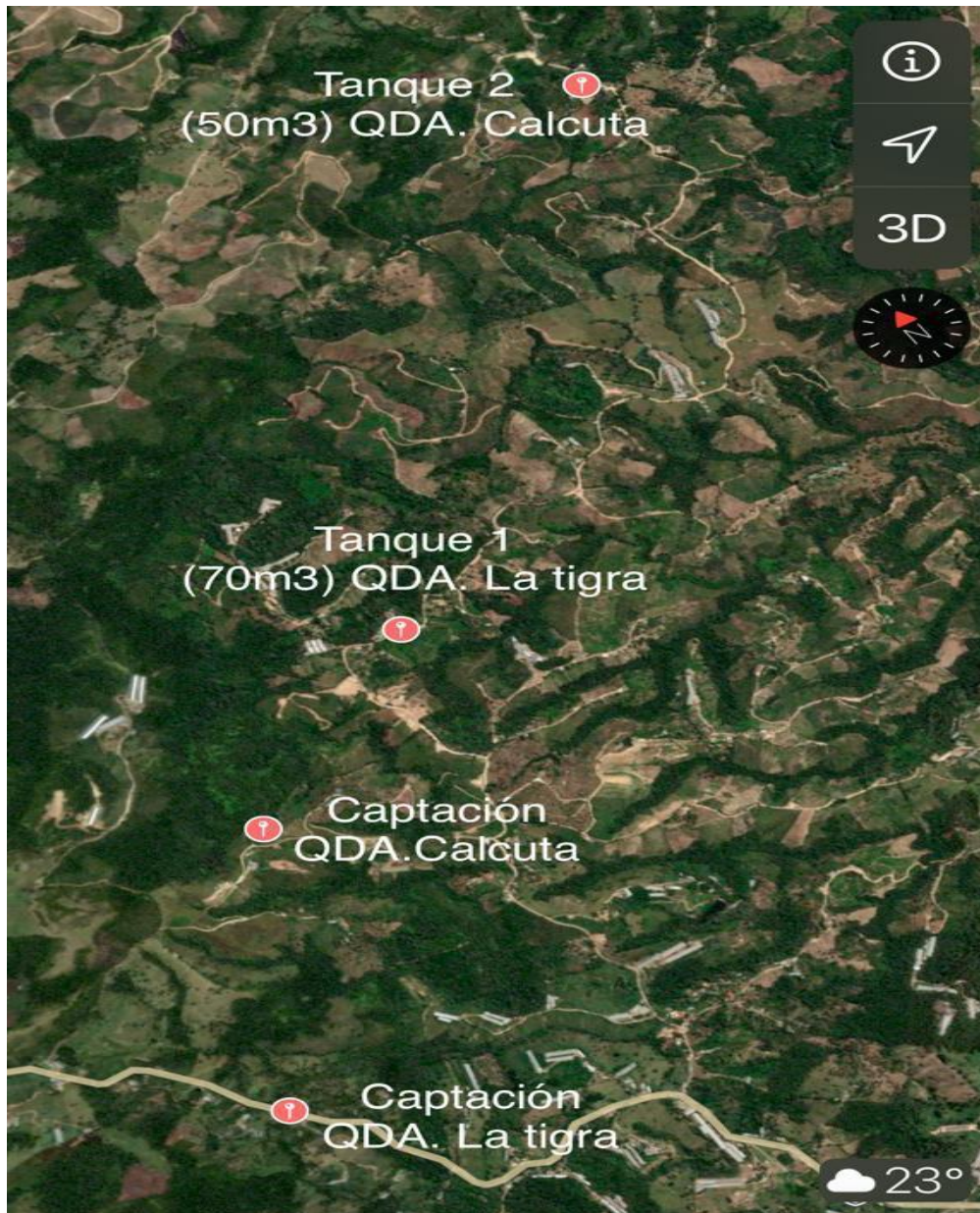
Ubicación Sistema de acueducto vereda cuzaman (2 Captaciones, 2 tanques de almacenamiento)
